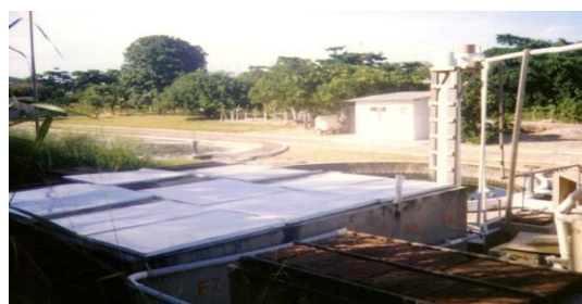
Figura 1: Decanto digestor com filtros anaeróbios
