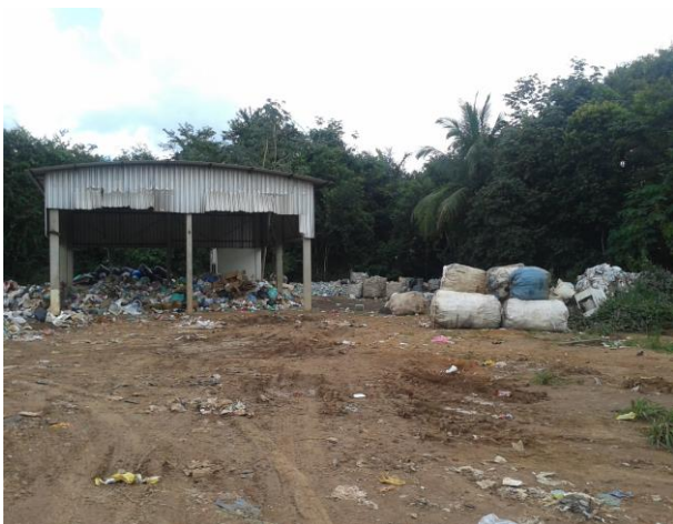
Figura 3: Barracão de triagem de materiais. Fonte: Relatório Quadrimestral (2014)
