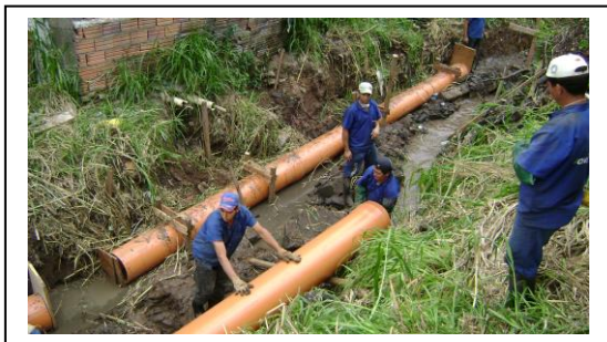
FIGURA 3 – Obra sendo realizada de forma manual com a utilização de tubulação de PVC.
