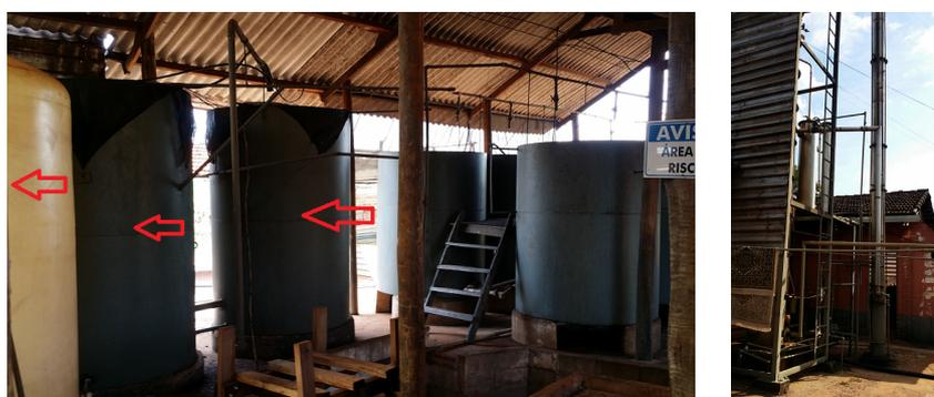
**Figura 4:** Dornas volante (esquerda) e coluna de destilação (direita)
