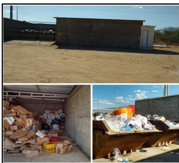
Figura 03 – Central de resíduos do Polo de Caruaru Fonte: Coleta de dados (2015)
