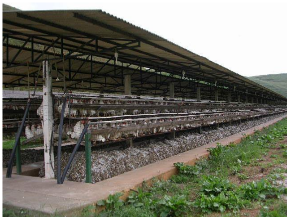
Figura 1: Instalação convencional com depósito de dejetos acumulados
