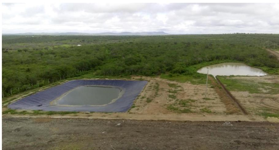
Figura 4 – Tanque de Evaporação e Lago do Aterro Sanitário EcoSolo (2016).
