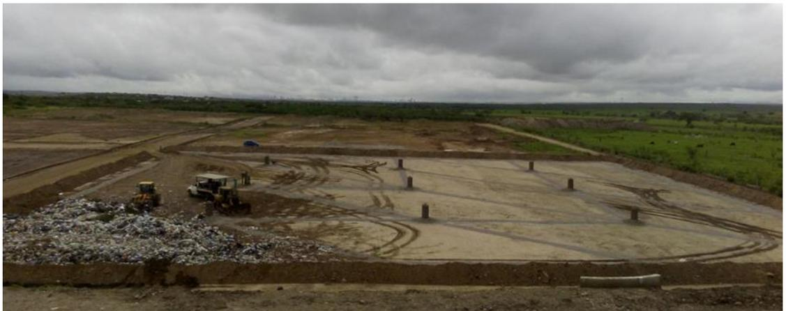
Figura 1 – Preparação de uma nova célula no Aterro Sanitário EcoSolo.
