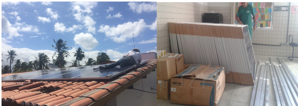
Figura 8 – Instalação das placas solares.
