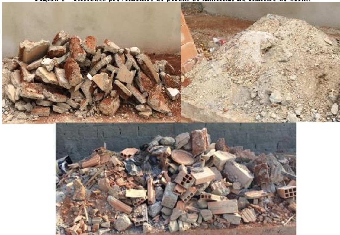
Figura 6 – Resíduos provenientes de perdas de materiais no canteiro de obras.
