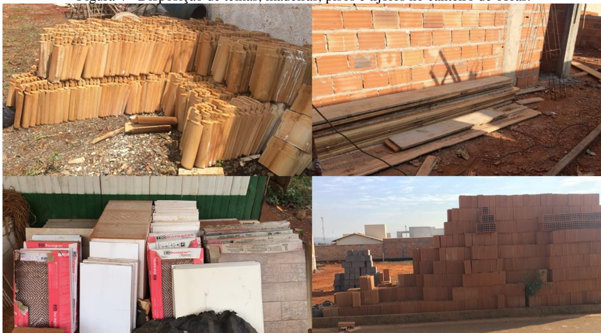
Figura 4 - Disposição de telhas, madeiras, pisos e tijolos no canteiro de obras.
