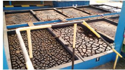
Figura 2. Vista Superior dos Leitos de Secagem. Fonte: Próprios Autores (2018).
