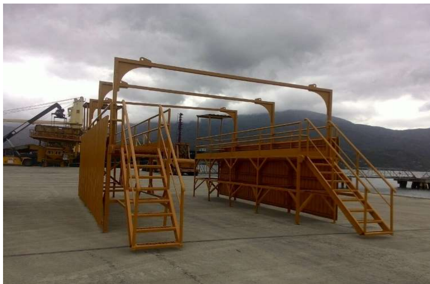
Figura 19: Passarela de enlonar caminhões após reforma.
