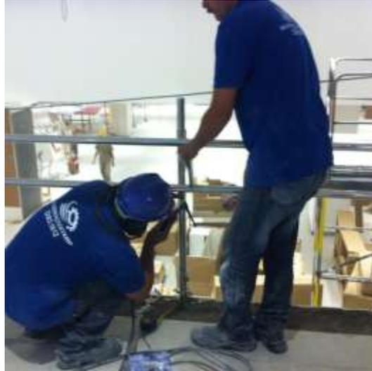
Figura 5 – Colaborador aplicando soldagem TIG
