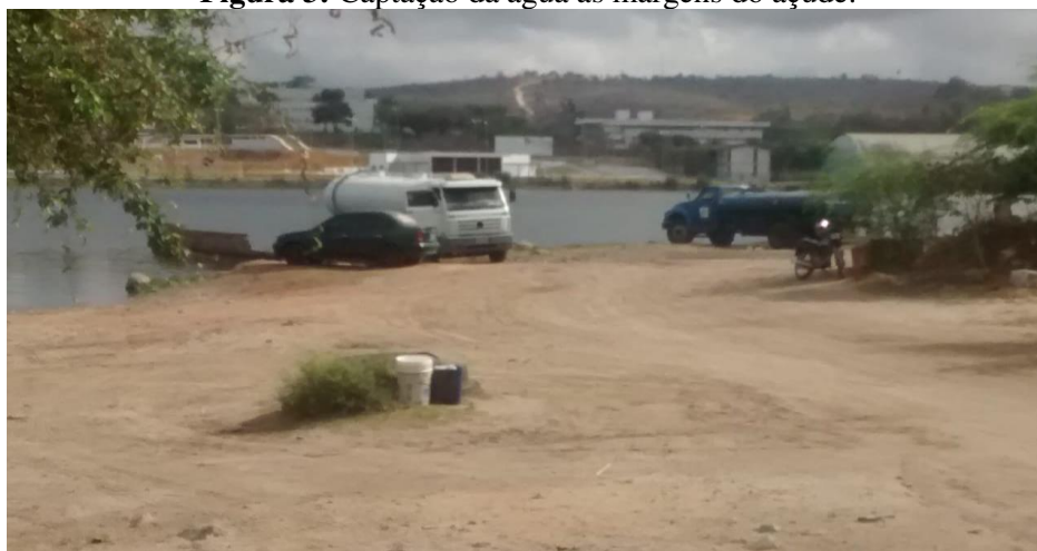
Figura 3: Captação da água às margens do açude.
