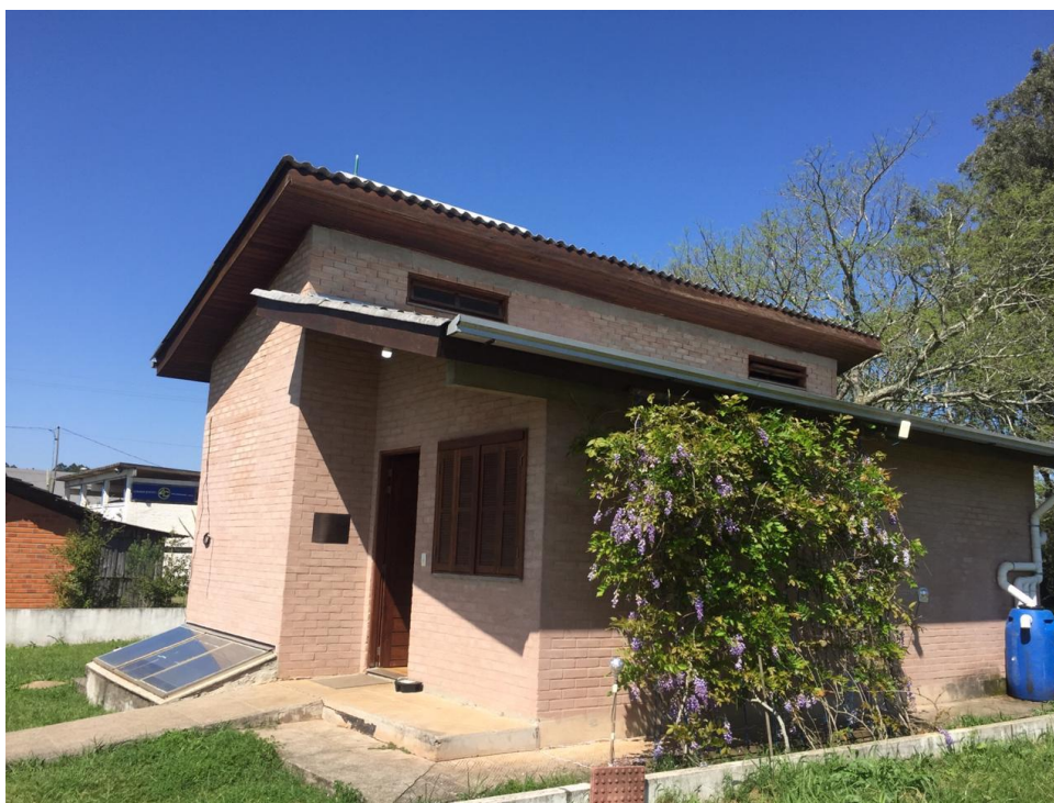
Figura 01: Casa Popular Eficiente, Centro de Eventos, Universidade Federal de Santa Maria.
