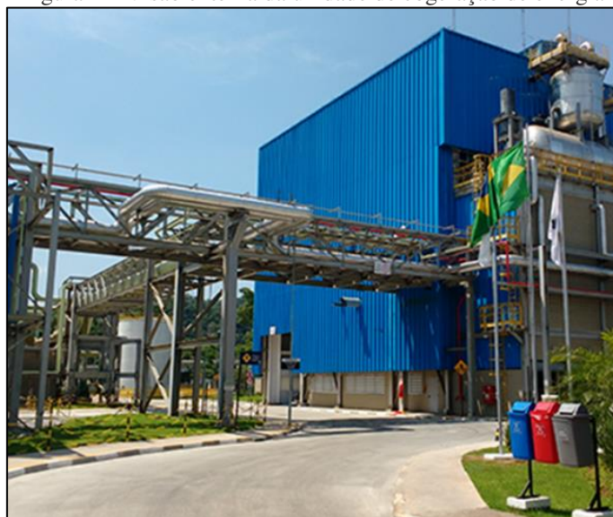
Figura 2 – Visão externa da unidade de cogeração de energia
