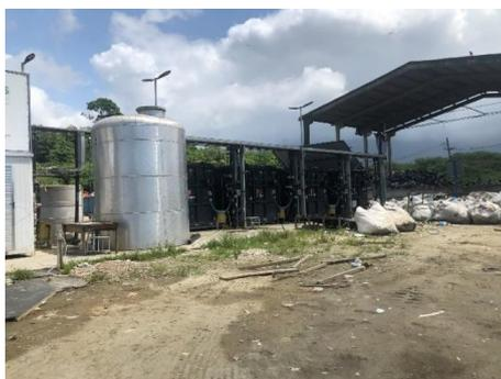
**Figura 10.** Equipamento de digestão anaeróbica. Fonte: Dados da Pesquisa.
