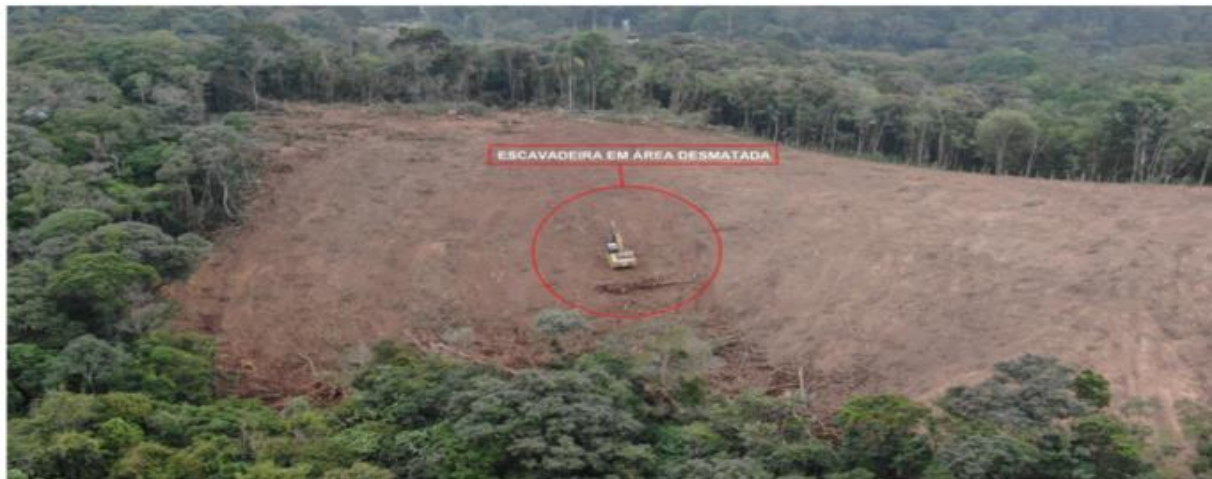
FIGURA 3: ESCAVADEIRA TRABALHANDO EM ÁREA DESMATADA
