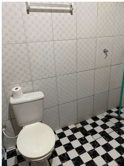
Banheiro lavado com utilização de material manual.
