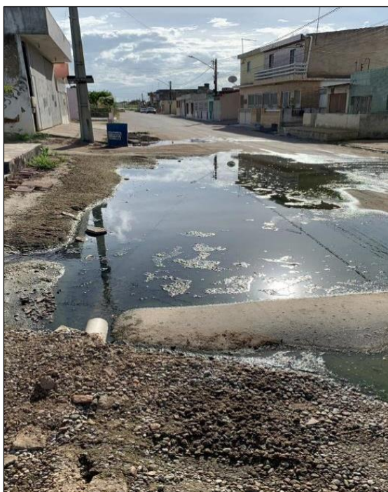
Figura 3 – Esgoto a céu aberto
