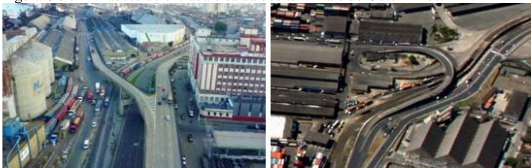
Figura 6 e 7 – Viaduto de entrada e saída dos terminais do Outeirinhos.
