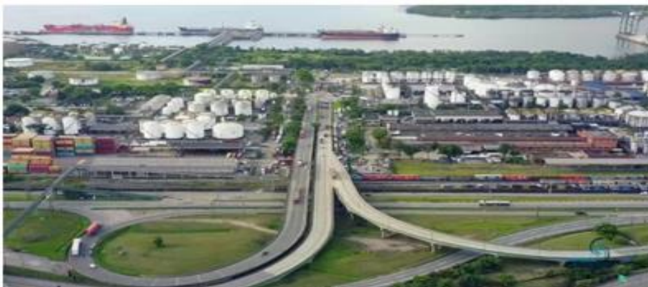
Figura 4 – Viaduto de acesso ao porto, região da Alamoá.
